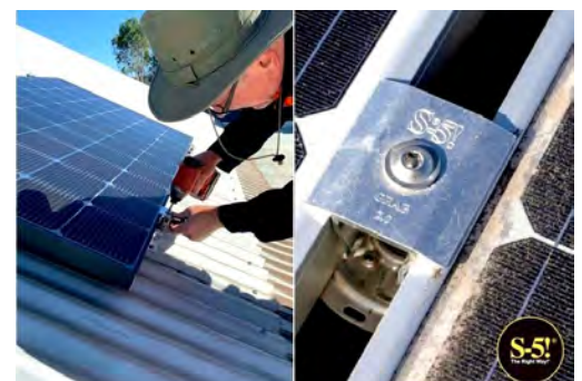
Dachparallele Montage quer zum Falz mit dem S-5!® PV-Kit 2.0 MidGrab : universell als End- und Mittel-Klemme einsetzbar.
